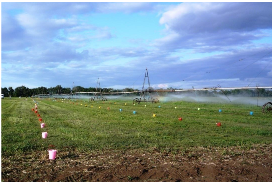
Рисунок 3.12 – Расстановка дождемеров вдоль водопроводящего трубопровода ДМ «Каскад»
