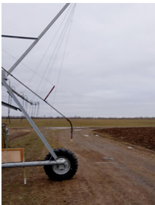
Рисунок 2.15 – Монтаж устройства приповерхностного дождевания в районе тележки (высота установки насадки 1,5 м от поверхности земли)
